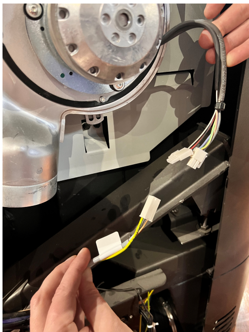
Fig. 47: Raccorder les câbles
